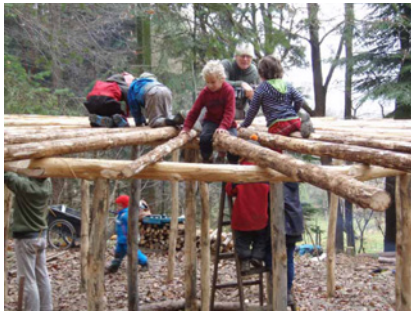
Das neue Feuerhaus im „wilden Wald“ im Bau
